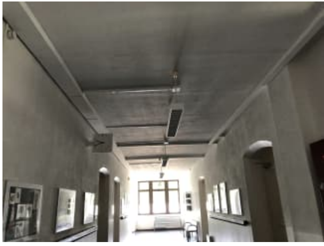
BS-Kanäle in den Flurbereichen (EG, 1.OG, 2.OG)
