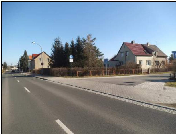
Foto: neugestalteter Straßenraum Beuchaer Straße
