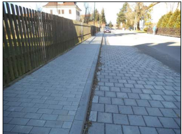
Foto: neugestalteter Straßenraum Poststraße
