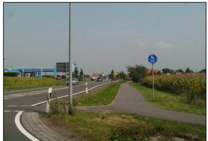
Foto: gemeinsamer Fuß- und Radweg Beuchaer Straße, Blick vom Kreisverkehr stadteinwärts
