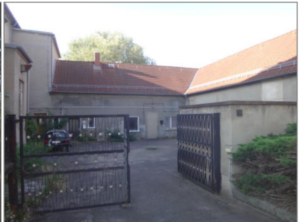
Abbildung 14: Blick in Innenhof
